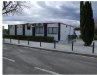
La nova comissaria dels Mossos a la Jonquera es construirà a la campa dels bombers
